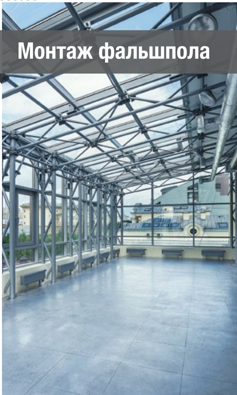
Штаб квартира Coldy Group Система фальшпола Jansen с использованием С-профилей 700 м2
