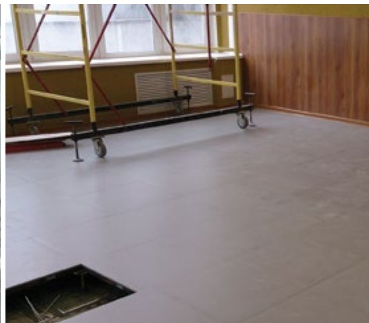
Центр управления полетами г. Королев Монтаж фальшпола из сульфата кальция с керамогранитом 800 м2
