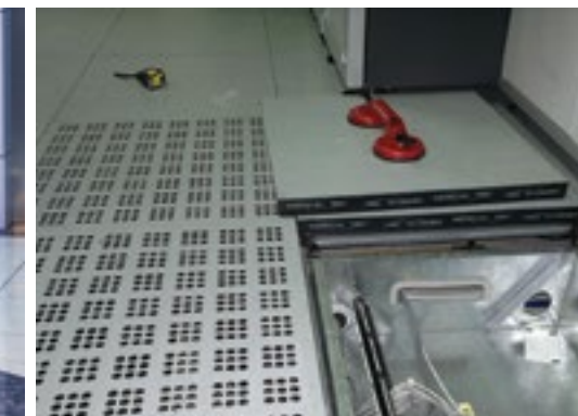
ЦОД МТС Монтаж фальшпола 2000 м2
