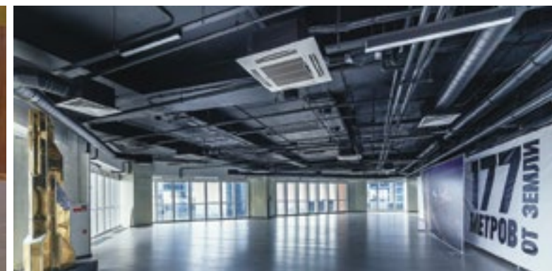
Башня Меркурий Монтаж фальшпола 1200 м2
